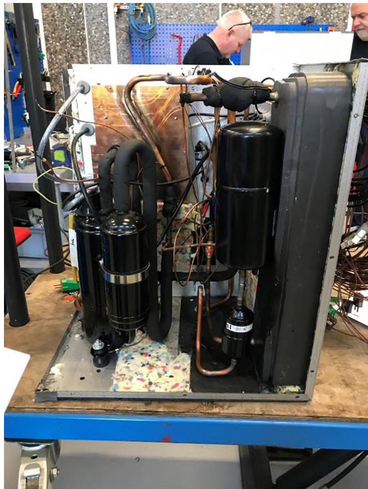
*Foto af opbygning af prototype 2 i prototypeværkstedet hos Nilan. Man ser kompressor og sugeakkumulator/olieudskiller bygget sammen forneden til venstre. Helt til højre er kondensatoren (pladevarmeveksler). Imellem er reciever og nedenunder denne: kålemiddelfilter.*
