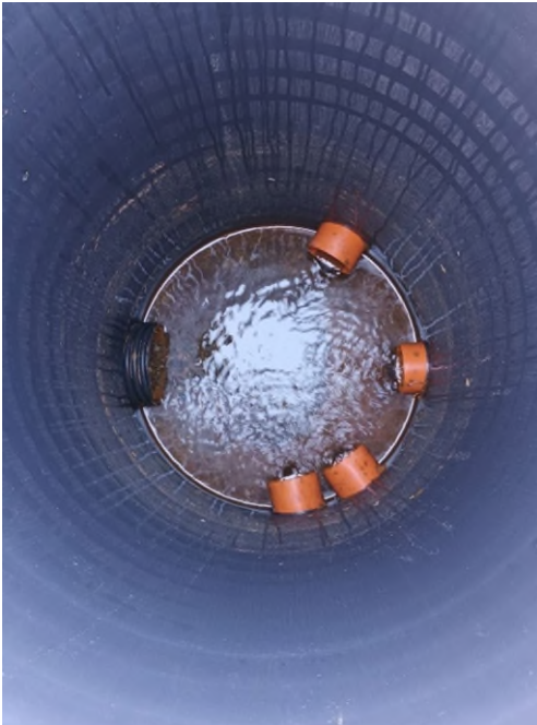
Figur 4.12. Eksempel på rensbrønd med flere tilløb.
