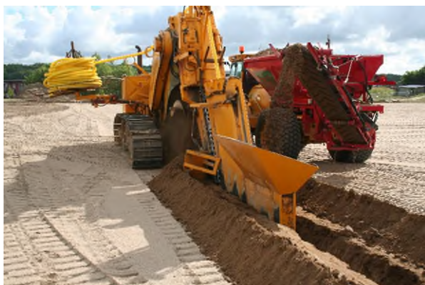
Figur 4.10. Kædegraver med sandvogn til ifyldning af filtermateriale.
