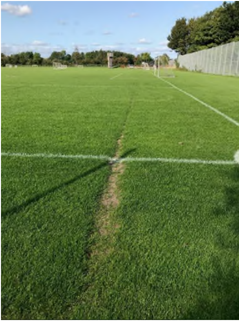
Figur 6.4. Udtørret græs over drænrender.
