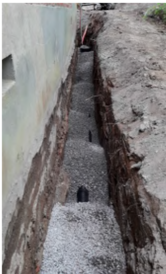
Figur 3.8. Granitskærver brugt som filtermateriale.
