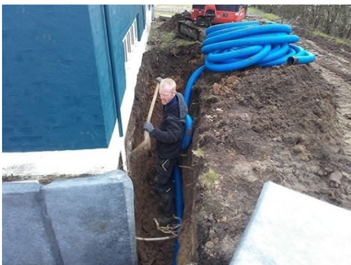
Figur 3.11. Korrugerede drænrør på ruller bruges ofte til omfangsdræn.
