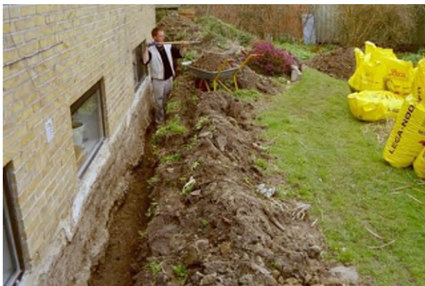
Figur 4.2. Frostfri dybde for et omfangsdræn er 0,6 m.
