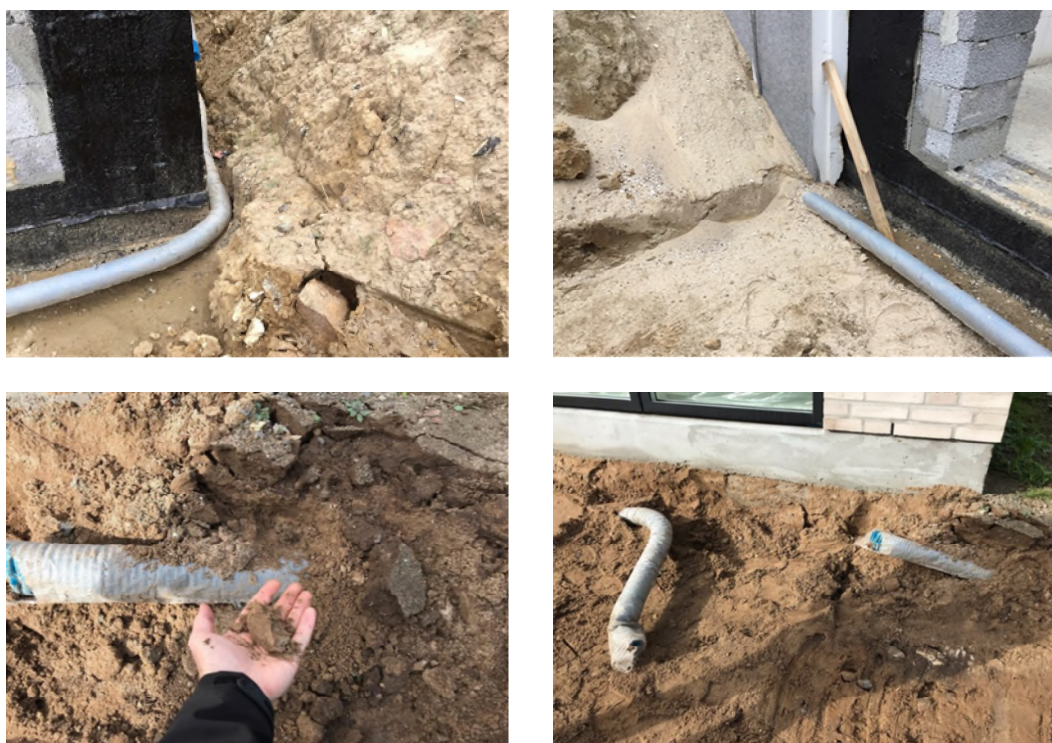
Figur 3.7. Eksempler på et drænsystem lagt med kompositdræn i en jord med fine partikler.
