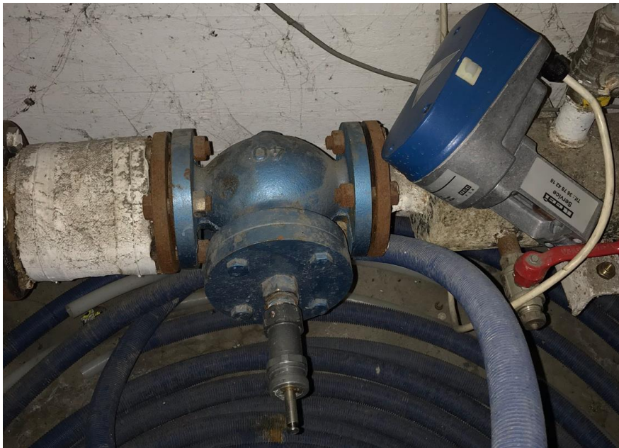
Motor pillet af motorventil.
