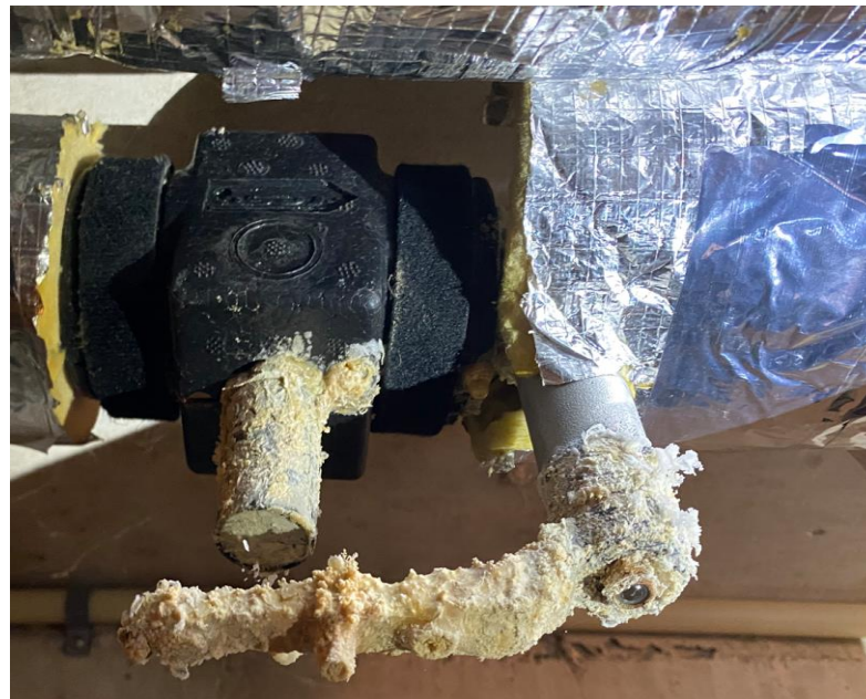
Indreguleringsventil på cirkulationsstreng defekt og utæt.
