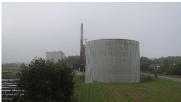
Figur 47: Akkumuleringstank med kamera og vejrstation ovenpå
