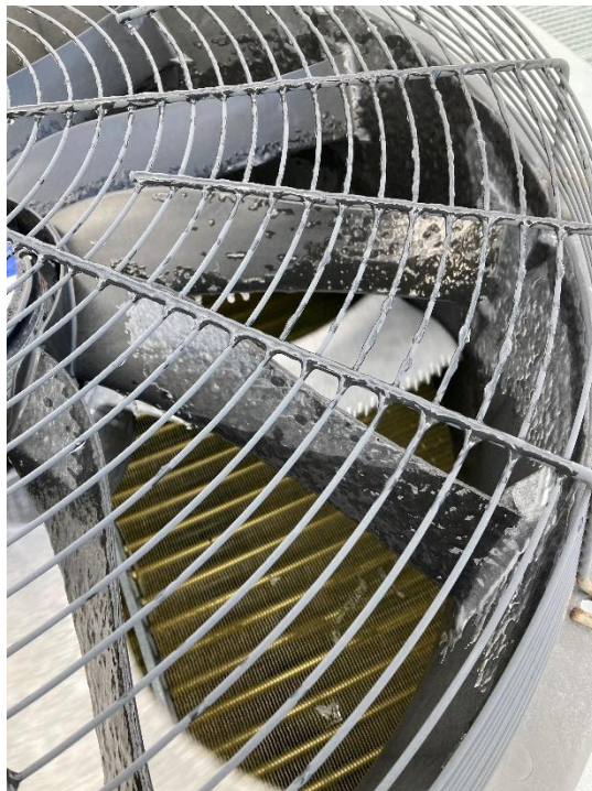
Figur 33: Isopbygning på blæservinger, gitter og omgivende diffusor (2022.01.19)
