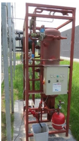
Figur 39: VSO'er - Vand-, Snavs- og Olieopsamlingssystem (2021.06.23)
