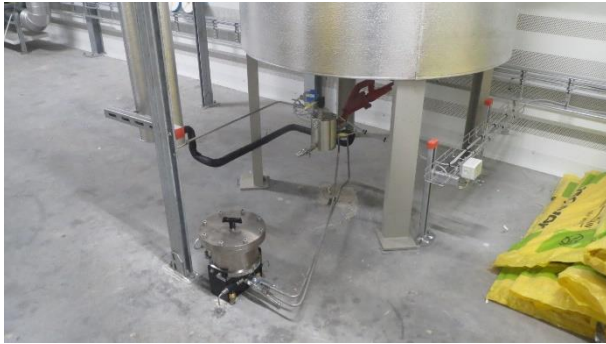
Figur 41: Specielt oliefilterarrangement (2021.10.08)
