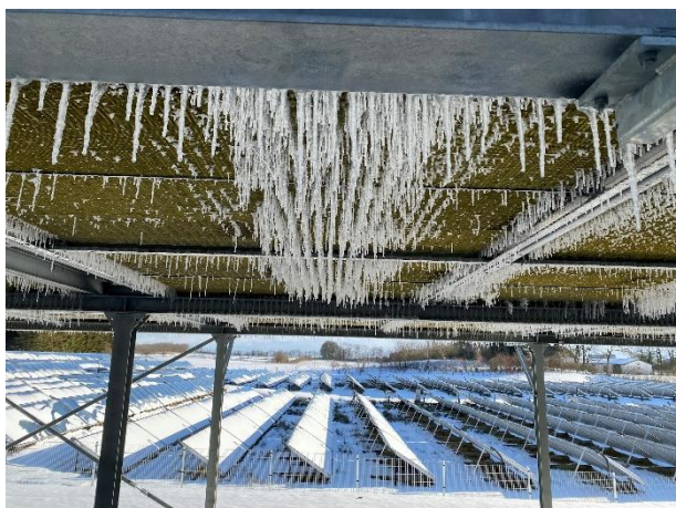
Figur 30: Tilrimning af fordamper (2021.02.10)
