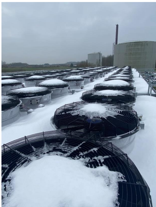
Figur 32: Is og sne ovenpå fordamperne (2022.01.03)
