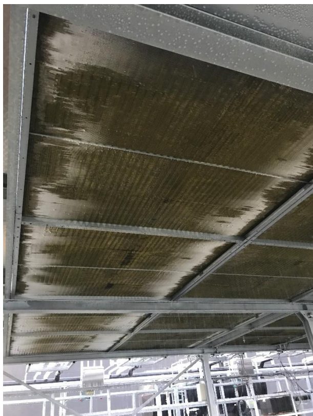
Figur 28: Tilrimning af fordamper (2020.11.26)
