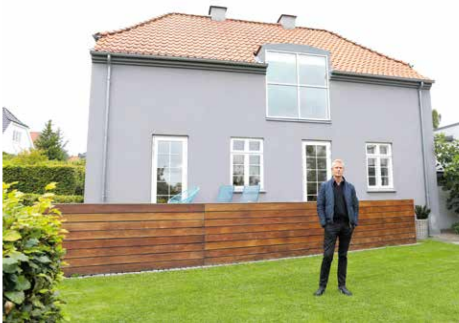
Foto 1. En jysk familie er glad for deres tidligere installerede luft-til-vand varmepumpe som del af et jordvarmeanlæg med væskeslange under græsplænen. Varmepumpen, der trods sin relativt beskedne fysiske størrelse (højde x bredde er 1,2 x 1,3 m) klarer opvarmningen og varmtvandsforsyningen i familiens 340 kvadratmeter ældre, men hvad angår varmetab velisolerede store patriciervilla.
