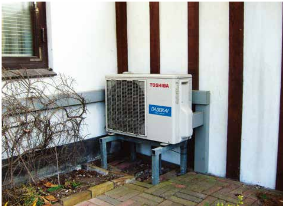
Foto 2. Luft-til-luft varmepumper er blevet populære og anbefales af Energistyrelsen i velisolerede parcel- og rækkehuse, idet de kan bidrage som supplement til eksisterende olie- eller gasopvarmning i opvarmningssæsonen. Endvidere kan de yderligere levere aircondition i sommerperioden, idet varmepumpens normale varmeprocess kan vendes til en køleproces.
