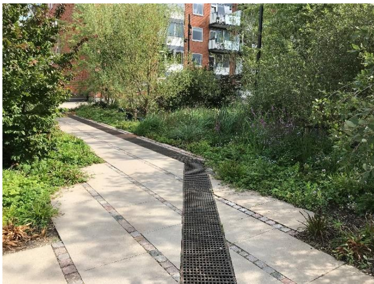
Figur 4: De nyudviklede skybrudsrender med specielle riste. De er svære at vedligeholde og ristene er ikke holdbare. Foto: Teknologisk Institut.
