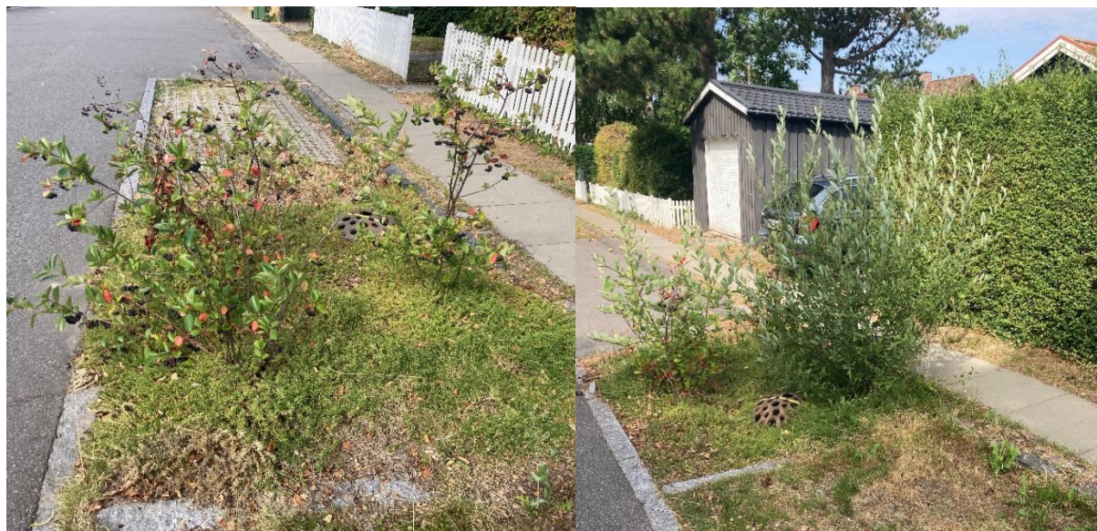
Figur 3: To af samme type regnbed ved Gedvad, Bagsværd, til højre med invasiv vækst af pil. Fotos: Teknologisk Institut.
