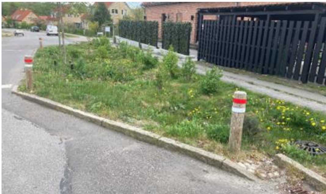
Figur 4: Vejbed med erosionsbeskyttelse i indløb, Risvangen, Aarhus. Fotos: Teknologisk Institut.
