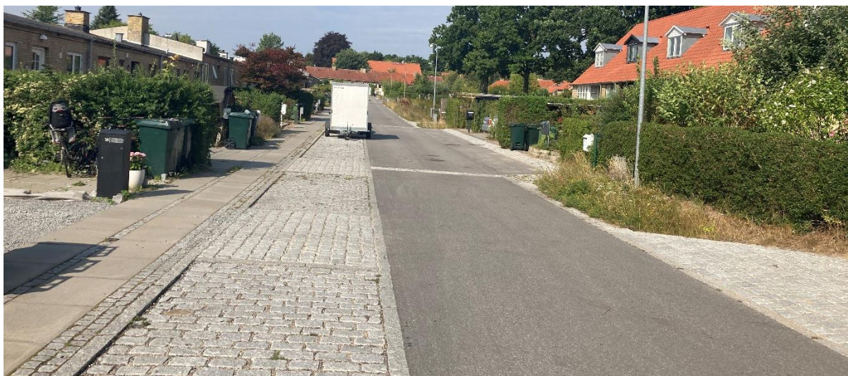
Figur 5: Parkeringsarealer med permeabel befæstelse, Gedvad, Bagsværd. Foto: Teknologisk Institut.
