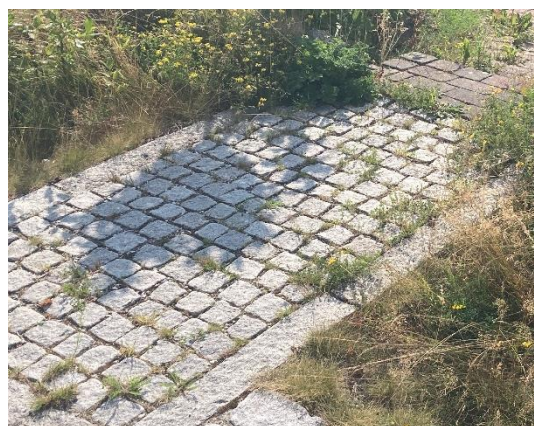
Figur 9: Uønsket vækst i permeabel belægning. Foto: Teknologisk Institut.
