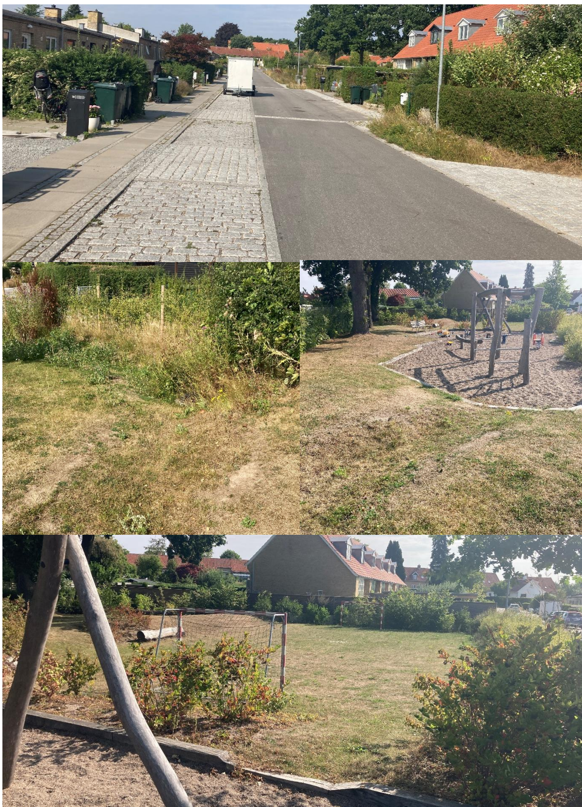
Figur 7: LAR-anlæg på Hørmarken, Gedvad område 2, august 2022. Parkeringsarealer med permeabel belægning (øverst) samt overløbs-/skybrudsbassin på legeplads og boldbane (midt og nederst). Fotos: Teknologisk Institut.
