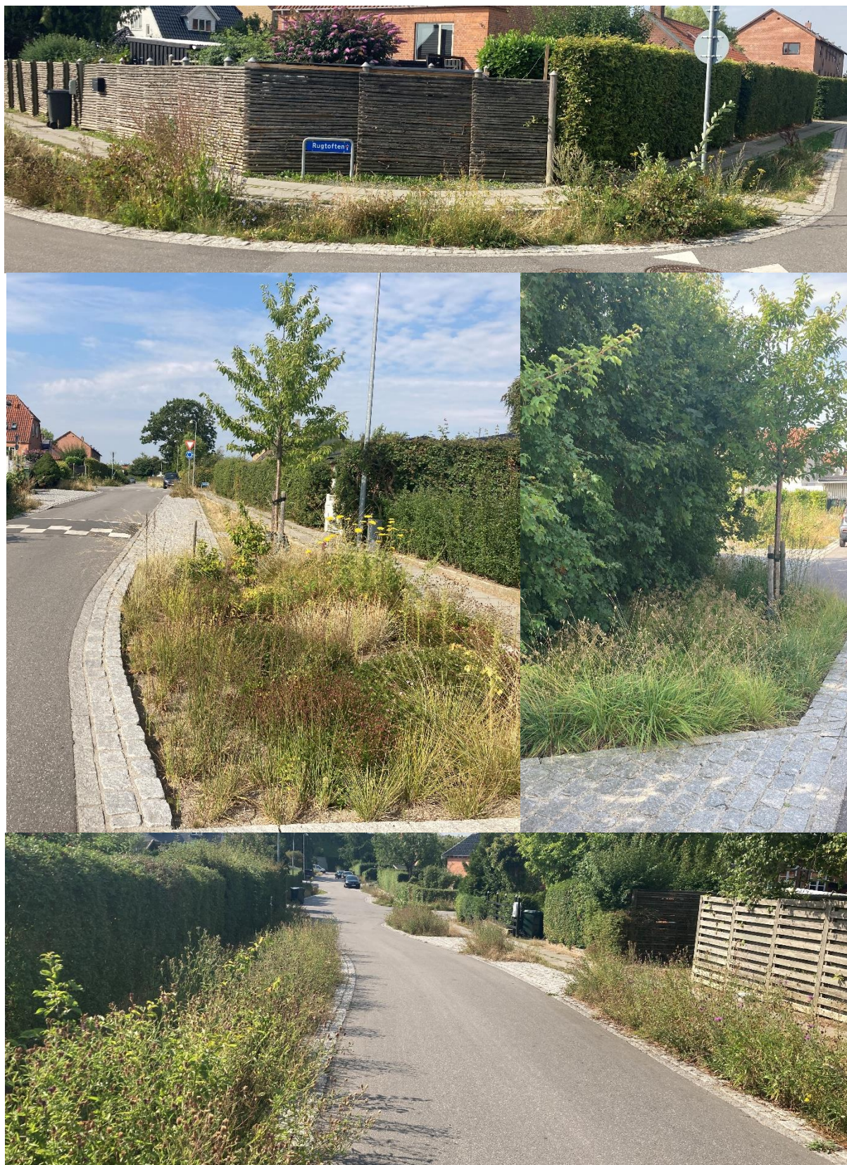
Figur 6: LAR-anlæg i Gedvad område 2, august 2022. Regnbede i rundkørsel Bondemarken/Rugtoften (øverst); regnbede på Bondemarken (nederst). Fotos: Teknologisk Institut.
