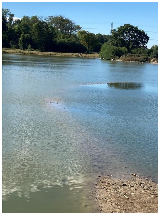
Figur 5: Undersøiske volde som afgrænsning af indløbsbassin/sandfang. Foto: Teknologisk Institut.
