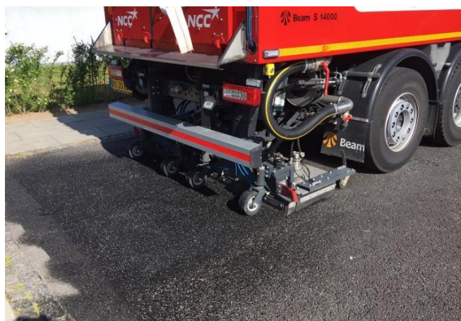
Figur 5: Rensning af asfalt med specialdesignede vogne. Foto: NCC.
