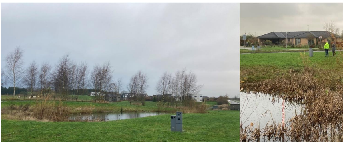
Figur 2: Overløbssø, der dræner Dalbyvej. Fotos: Teknologisk Institut.
