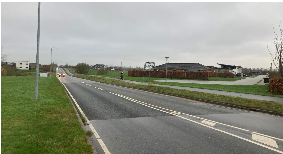
Figur 1: Den permeable del af Dalbyvej ses her ved den mørkere asfalt. Foto: Teknologisk Institut.
