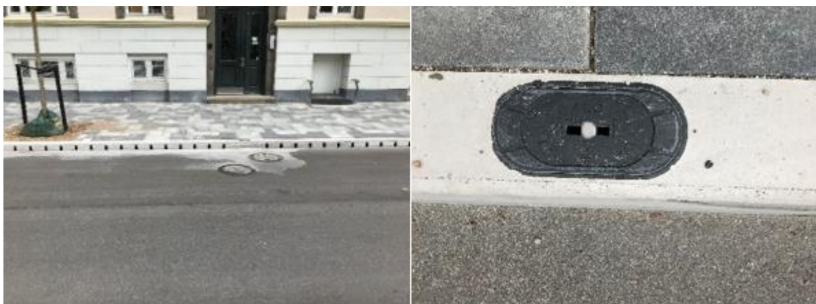
Figur 4: Indløb fra faskine til vejen (venstre) og spjæld (højre). Fotos: Teknologisk Institut.
