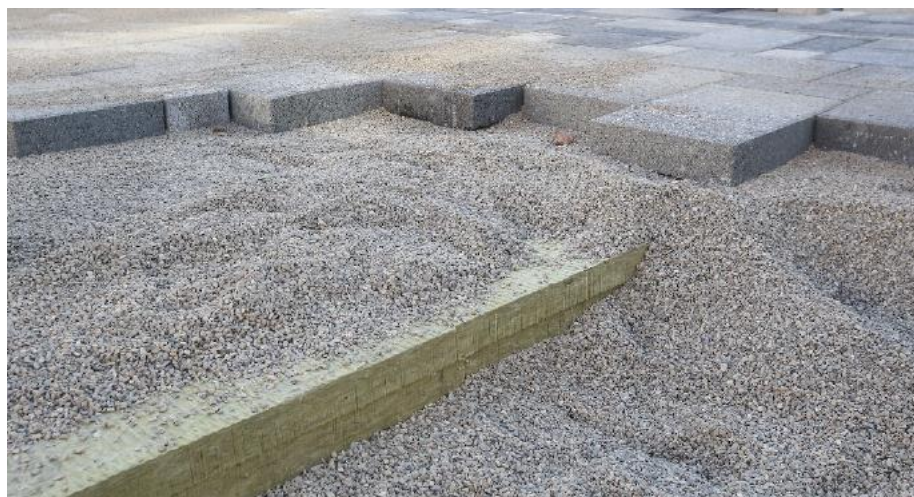
Figur 2: Opbygning af faskine, bærelag og fliser. Foto: Dines Jørgensen & Co. A/S – Referenceblad, Langelands Plads – Skybrudssikring.
