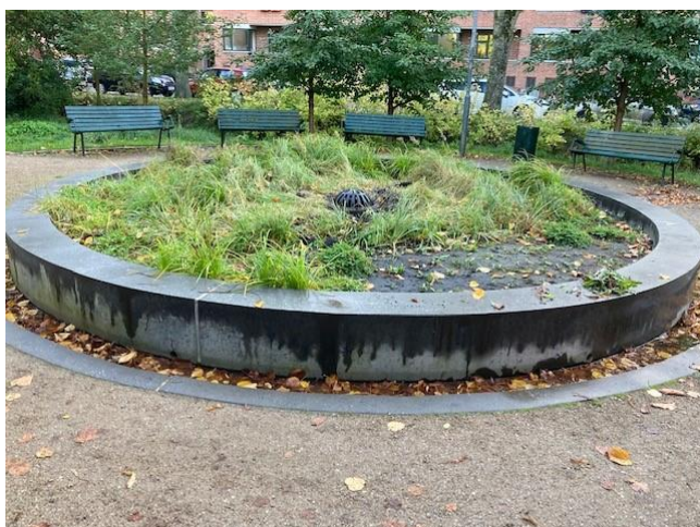
Figur 3: Regnvandet pumpes ind gennem risten øverst i Kilden og derefter siver regnvandet gennem jordfiltret og ud i renden omkring Kilden. Foto: Teknologisk Institut.
