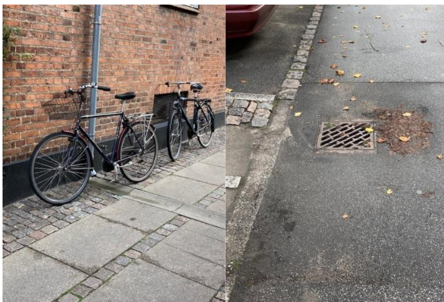
Figur 2: Tagvand ledes ud på vejoverflader og gennem skybrudsriste til en separat regnvandsledning. Fotos: Teknologisk Institut.
