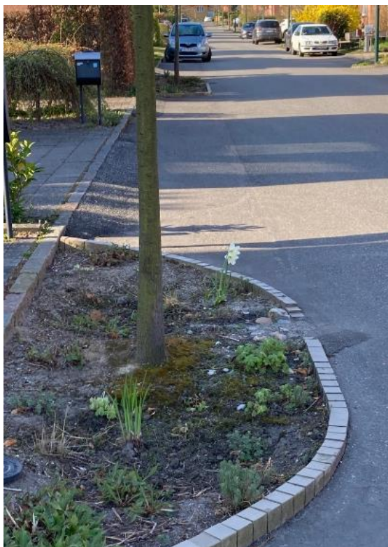
Figur 5: Asfaltkant, der skal lede vejvandet ind i vejbedet.
