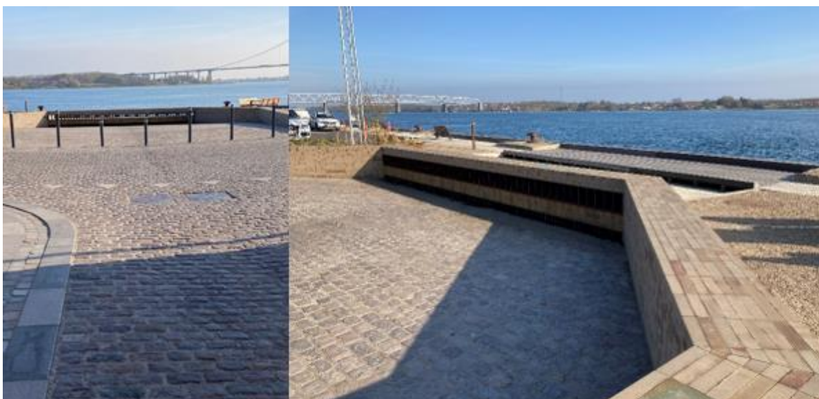
Figur 3: Havnepladsen med udløb til Lillebælt, og med mulighed for ophold på anlægget. Fotos: Teknologisk Institut.
