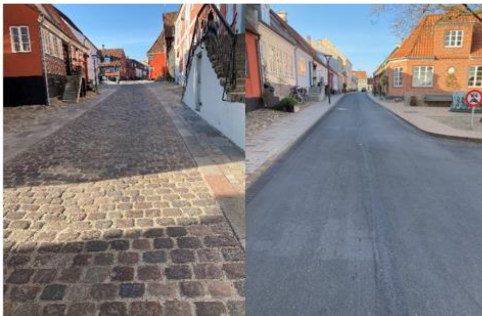
Figur 2: Brogade, hvor vejens trugform er udført med brosten, og andre gader, hvor vejprofilen er trugformet og udført i asfalt. Fotos: Teknologisk Institut.
