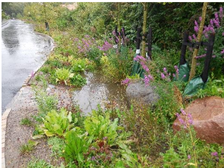
Figur 2: Indløb til vejbedene er erosionsbeskyttet. Foto: Teknologisk Institut.
