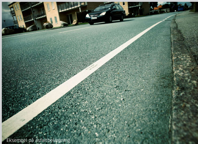
Eksempel på asfaltbelægning
