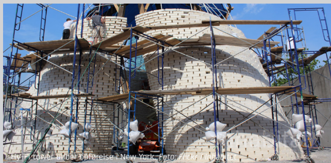
Hy-Fi tower under opførelse i New York. Foto: Flickr / N. M. B.
