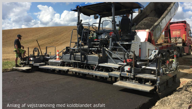
Anlæg af vejstrækning med koldblandet asfalt
