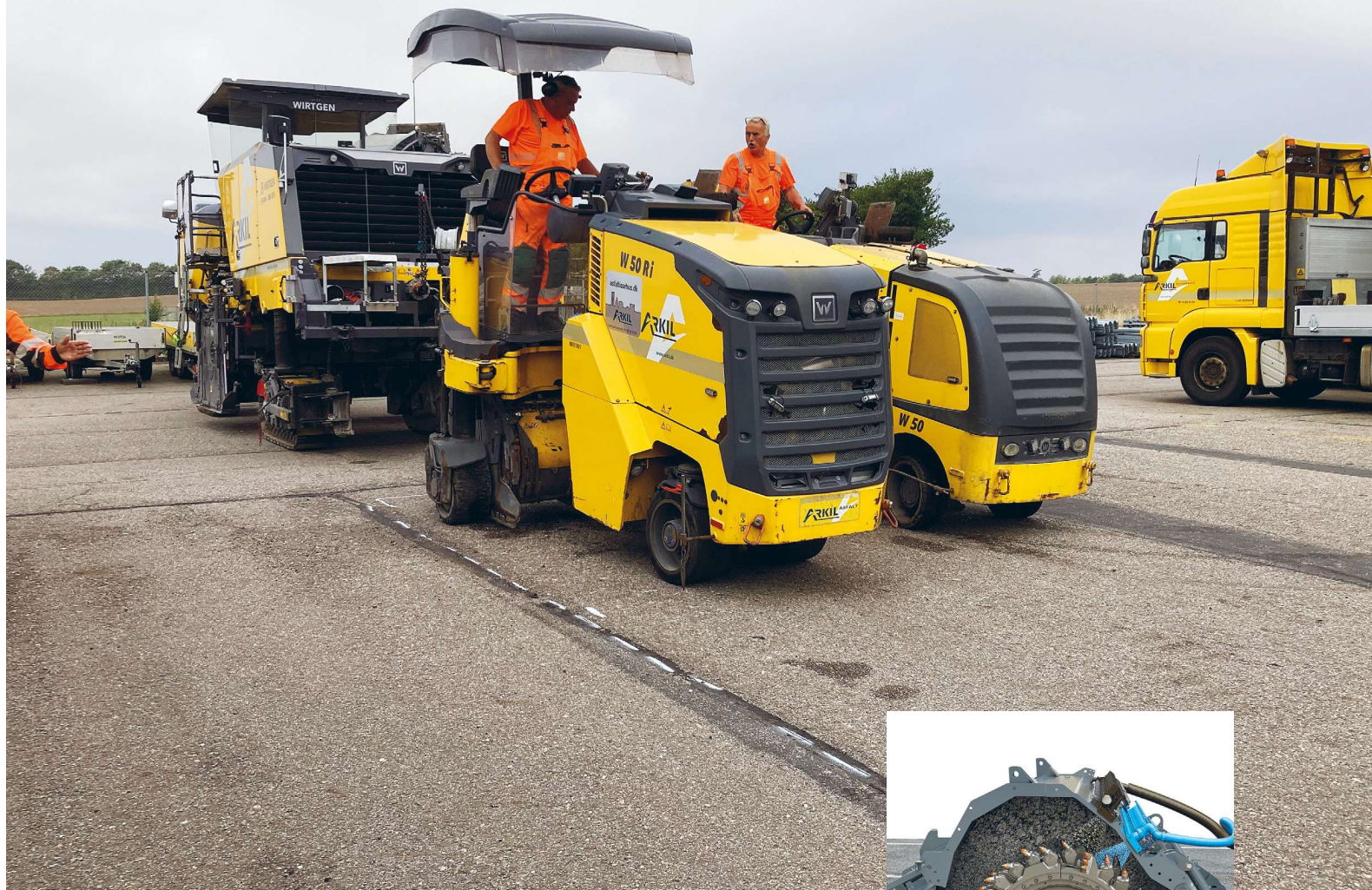
Fræseforsøg: I forgrunden to 1m-fræsere med henholdsvis standard- og finvalse. I baggrunden en Wirtgen CRi BSM fræse-/stabiliseringsmaskine.
