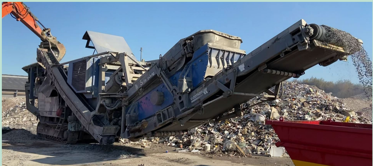
FIGUR 28. Neddelling af asbestfri eternitplader med kæbeknuser.
