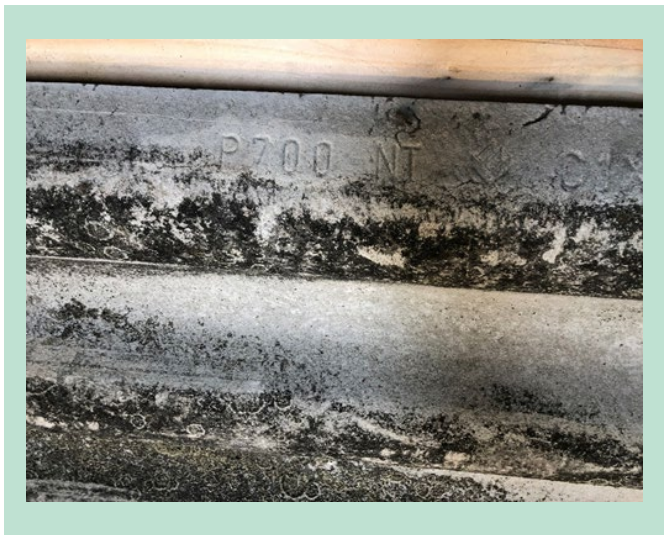
FIGUR 21. Eternitplade efter afrensning med laser - prægning i pladen fremstår tydeligt.
