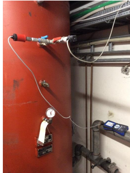
Figur 3.3.2 Tryktransducer på beholder.
