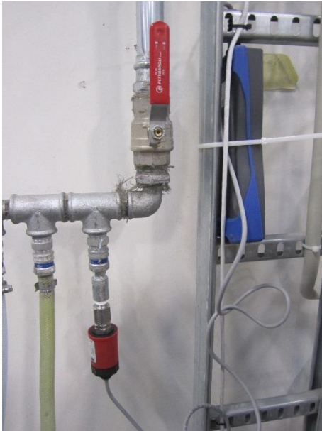
Figur 3.3.1 Tryktransducer på rør.
