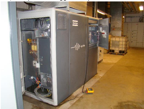
Figur 3.4.1 Effektmåler på kompressor.
