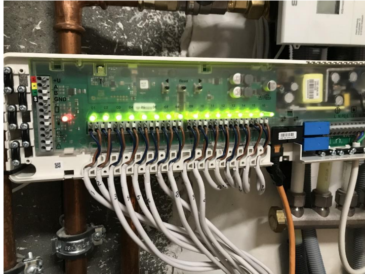
Figur 23 Tilslutning af Danfoss-telestater i Wavin-gulvvarmeboks.
