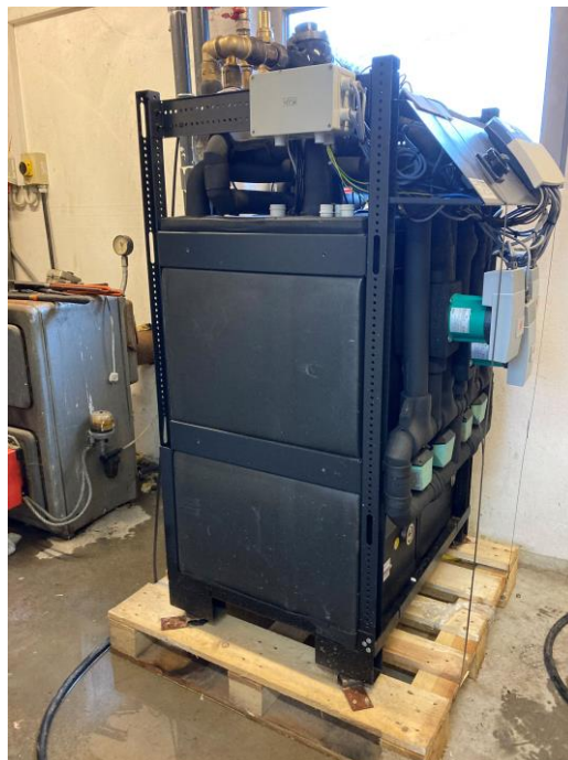
Figur 1. Adsorptionskøleren klar til at blive monteret.
