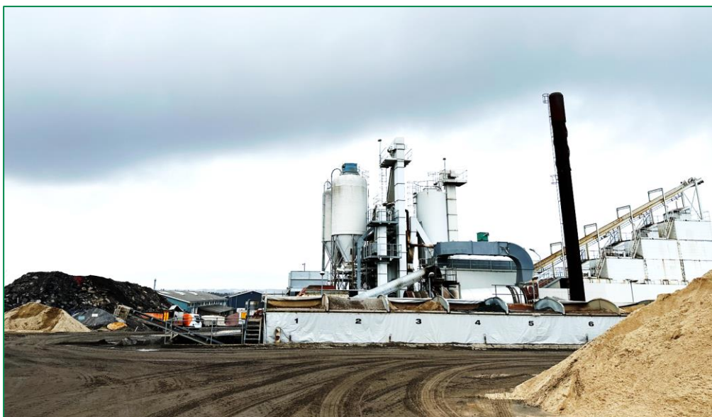
Fig. 11.1: Peab Asfalts fabrik i Uldum blev ombygget for optimering af genbrugsdosering.
