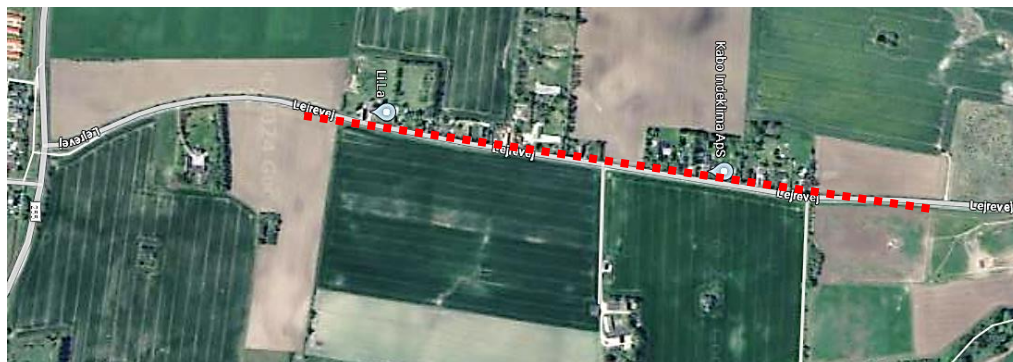
Fig. 12.3.1: Lejrevej i Lejre Kommune, opstart fra svinget ved Hvalsøvej i syd og retning mod nord (t.h. på foto) i begge vejsider (Placeringsangivelsen på kortet er omtrentlig)..
