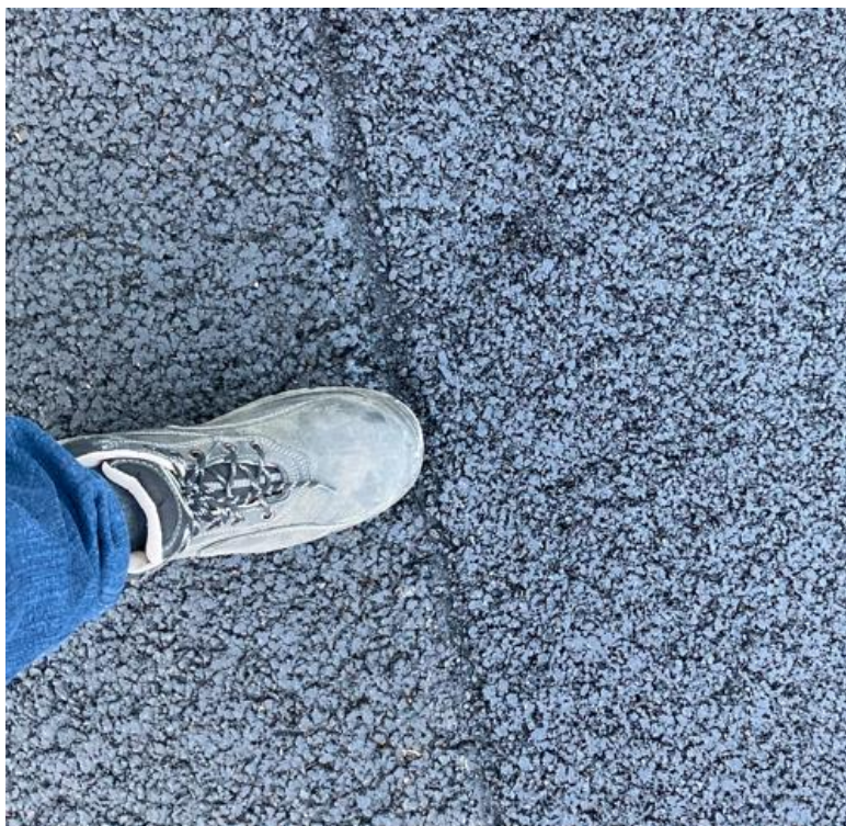
Fig. 10.1.3: Nærbillede af belægningernes overfladetekstur efter netop afsluttet tromling. SMA 8 XLN til venstre for samlingen ("sko-siden" på billedet) og SMA 6+11 XLN til højre. Det ses at begge udviser et finmasket net af små hulrum i overfladen – præcis som ønsket.
