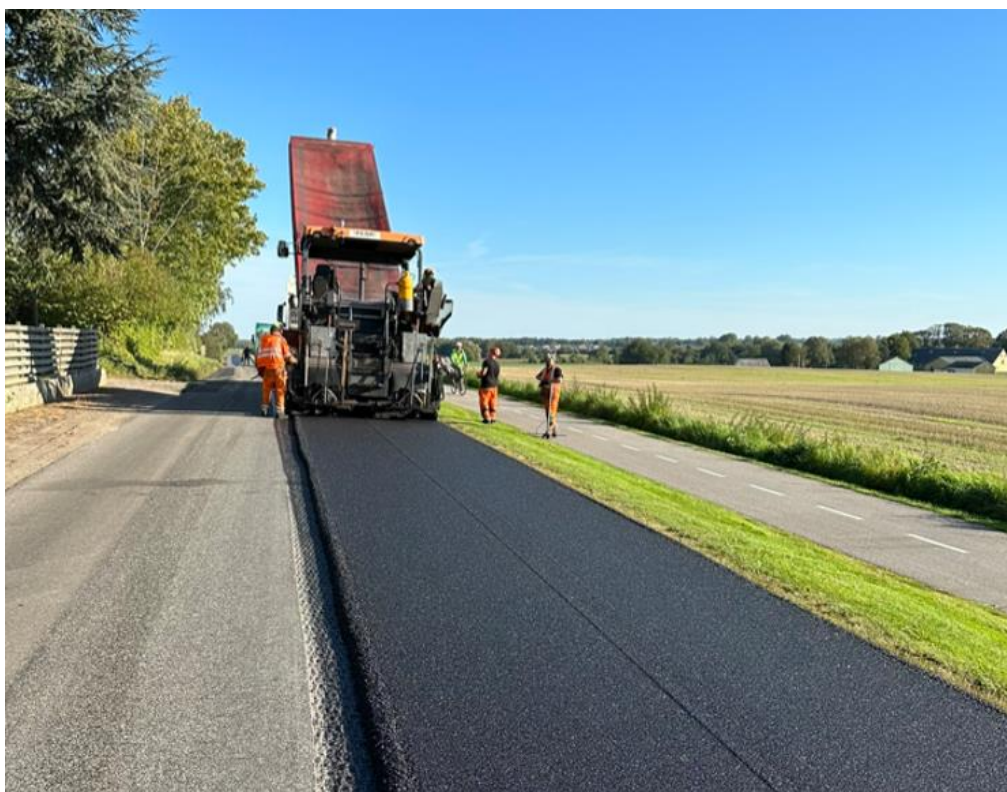
Fig. 12.3.3: Peab Asfalt udlægger SMA 8 XLN på Lejrevej, Lejre Kommune.
