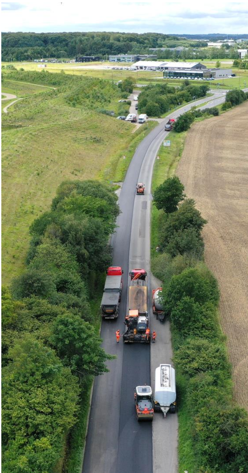
Fig. 12.2.3: Luffoto af Peab Asfalts udlægning af SMA 8 XLN på Juelsmindevej. Nær vejen er et nyt boligkvarter under opførelse.
