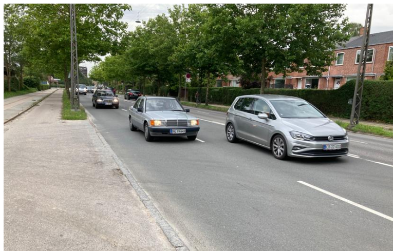
Fig. 13.9.2: Vejtrafik på SMA 6+11 XLN og SMA 8 XLN udlagt i 2022. Bemærk den korte afstand til rækkehusbebyggelsen på den modsatte side af vejen. Her opnås med SMA 8 XLN en "usynlig" miljøgevinst på 3 dB sænkning af støjniveauet.
