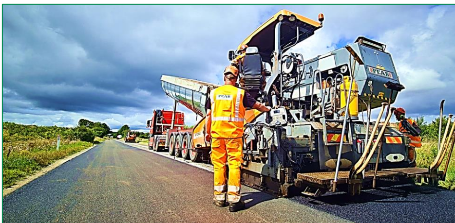
Fig. 12.2.5: Peab Asfalts udlægning af SMA 8 XLN
