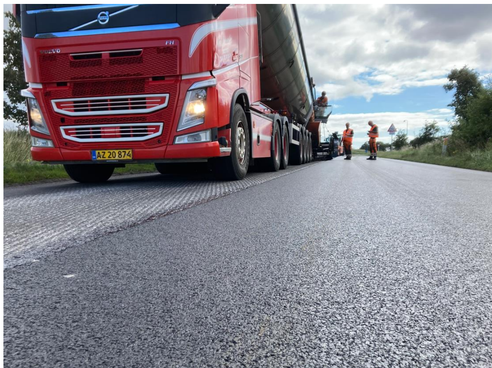
Fig. 12.2.2: Peab Asfalt udlægger SMA 8 XLN på Juelsmindevej i Vejle.
