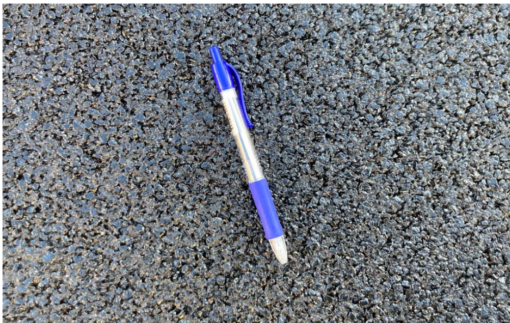
Fig. 12.4.4: Close-up af SMA 6 XLN-belægningens finkornede tekstur. Der ses en tydelig og ensartet porestruktur i overfladen.
