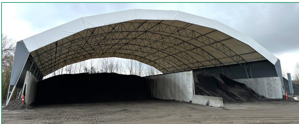
Fig. 11.2: Tørrehal for overdækket opbevaring af forskellige typer knust genbrugsasfalt
