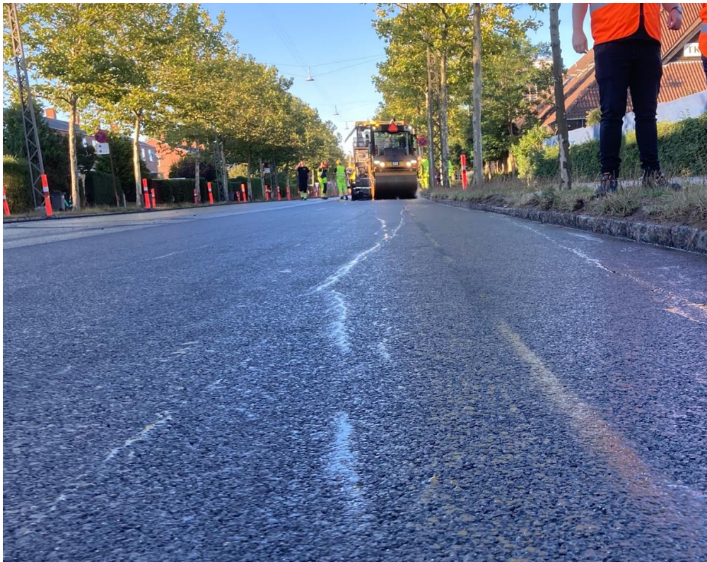
Fig. 10.1.2: Opstart af udlægning af SMA 6+11 XLN på en del af Tuborgvej, august 2022. De blanke spor på belægningen på billedet er blot vand, anvendt som slipmiddel på vejtrømlernes valser. Flot jævnhed og ønsket tekstur.
