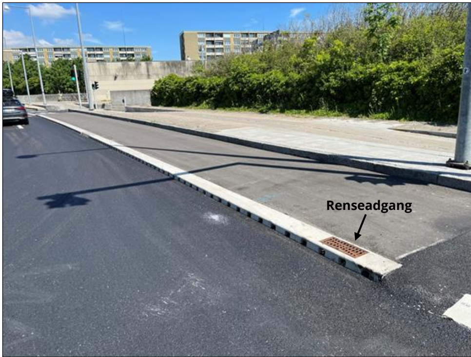
Figur 2.5. Linjeafvanding i kantstenen på en bro.
