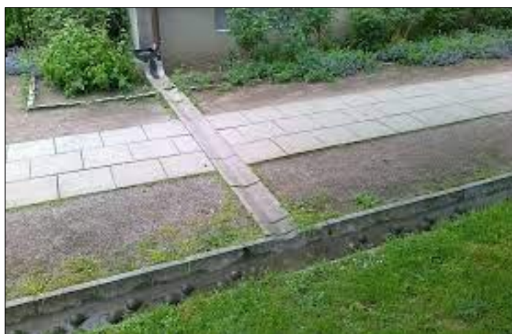
Figur 2.2. En Kinnekullerende er en rende fra tagnedløbsrøret hen over fortovet og ud til gaden. Kinnekullerender er mest brugt i gamle bymidter.
