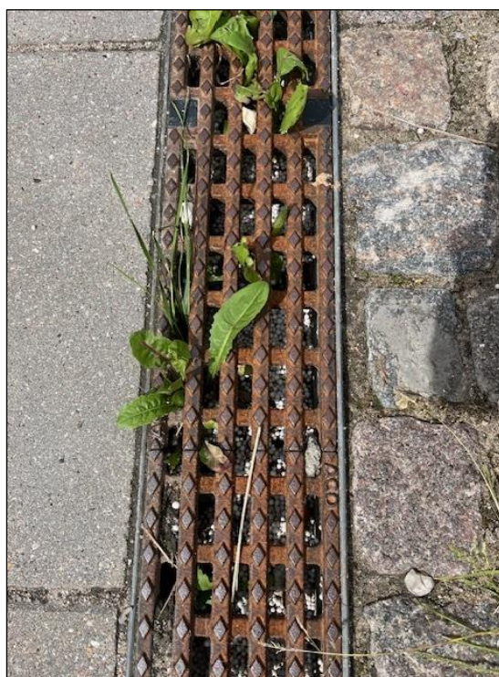
Figur 5.10. Afløbsrender kan ikke fungere uden vedligeholdelse.
