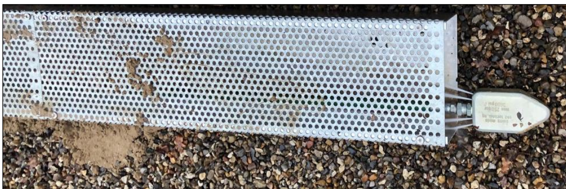
Figur 7.3. Eksempel på spuling af en afløbsrende med et spulehoved, hvor dyserne kun vender nedad.
