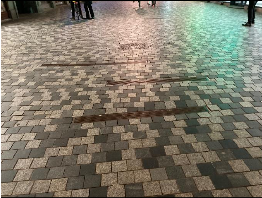
Figur 4.5. Ved veje med fald kan man installere flere render parallelt for at fange vandet.
