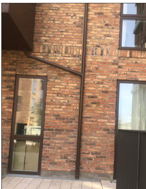
Figur 13.6. Regnvand fra altaner ført til en meget lille sokkelrende foran indgangsdøren.
