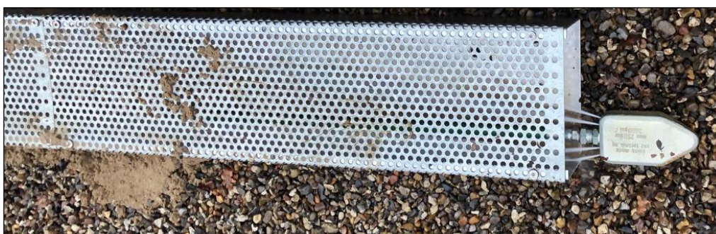
Figur 11.4. Eksempel på spuling af en sokkelrende med et spulehoved, hvor dyserne kun vender nedad.
