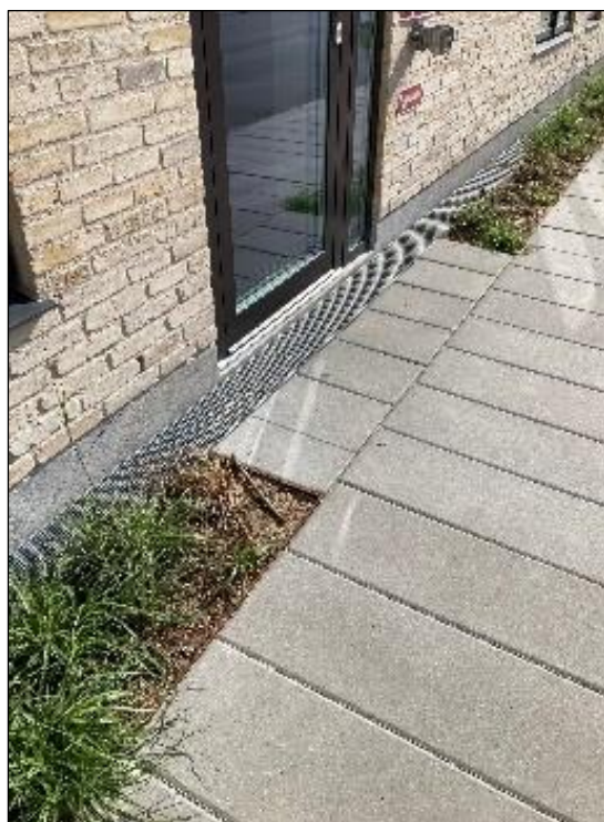
Figur 12.5. Nyt byggeri med både 150 mm fri sokkelhøjde og sokkelrender rundt om hele bebyggelsen.
