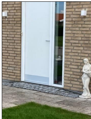
Figur 12.12. Mange parcelhuse bygges med 150 mm fri sokkelhøjde og hævet terræn/rampe ved indgangsdøre men uden sokkelrende ved døren.
