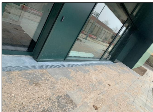
Figur 8.3. Tilbagetrukken facade med sokkelrende, der ikke følger facaden.
