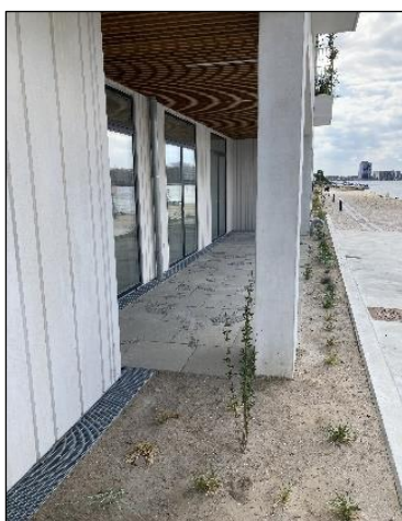
Figur 8.2. Tilbagetrukken facade med sokkelrende.
