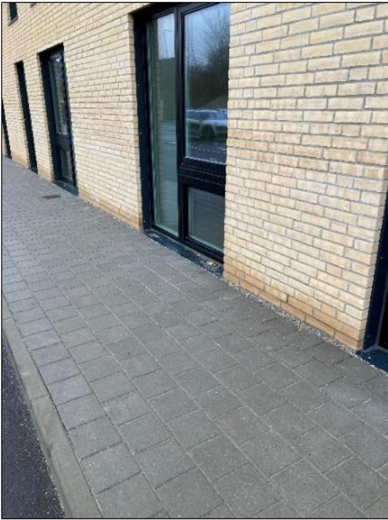
Figur 2.2. Nyopført etagebyggeri uden fri sokkelhøjde. Der ses allerede opfugtning og misfarvninger af facaden fra opsprøjt.
