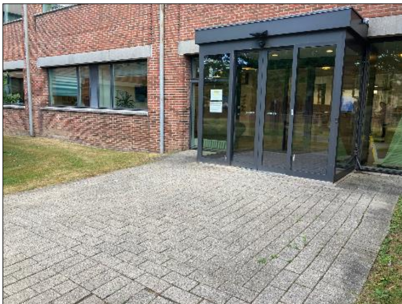
Figur 2.4. Niveaufri adgang med hævet terræn og uden sokkelrende i et eksisterende, ældre byggeri.
