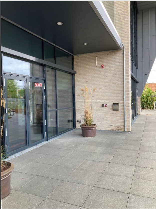
Figur 12.6. Ved det tilbagetrukne indgangsparti er det valgt af anvende sokkelrende.
