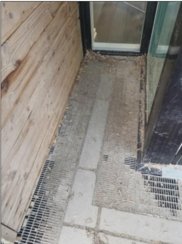
Figur 13.7. Sokkelrenden i børnehaven er fyldt helt op med sand.
