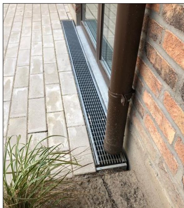
Figur 13.6. Regnvand fra altaner ført til en meget lille sokkelrende foran indgangsdøren.
