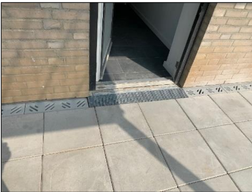
Figur 12.11. Niveaufri adgang med sokkelrende hele vejen rundt om huset.
