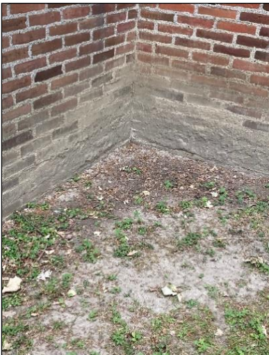
Figur 2.3. Snavs på facade efter opsprøjt.
