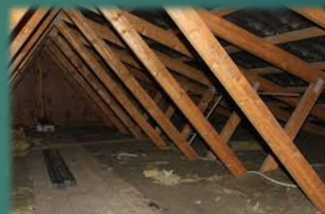
Koldtvandsrør ført i luftrum samisoleret med varmtvandsrør
