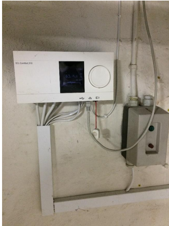
Figur 4.2 Regulator/udekompenseringsanlæg (ECL fra Danfoss)
