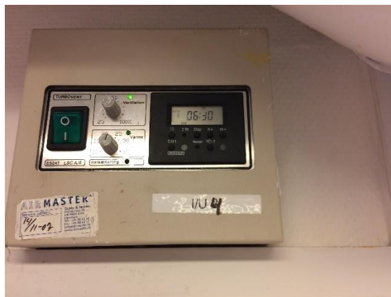
Figur 4.4. Decentral styring til ventilationsanlæg
