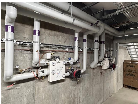
Figur 5.11. Varmesystem (fjernvarmeveksler)
