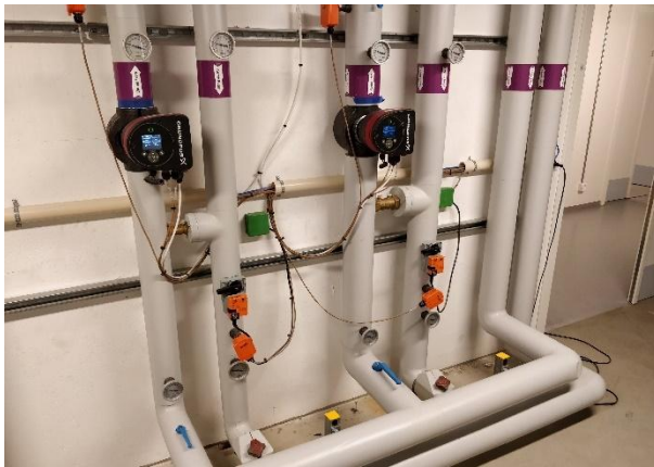
Figur 4.33 Blandekredse med omdrejningstalsregulerbare cirkulationspumper
