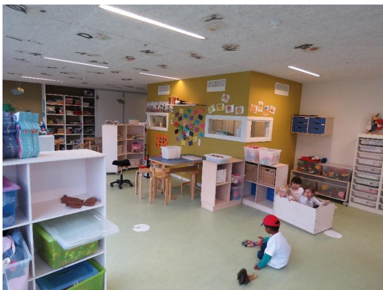
Figur 17 Belysningsanlæg med LED-armaturer samt PIR- og dagslyssensorer
