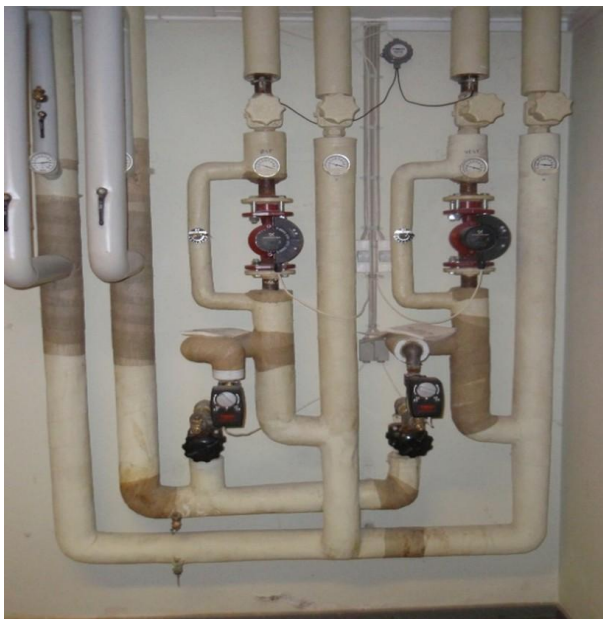
Figur 4.16. Blandekredse til radiatorsystemer og omdrejningstalsregulerbare cirkulationspumper
