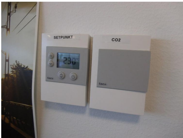
Figur 4.31. Temperatur- og CO 2 -sensor på væg
