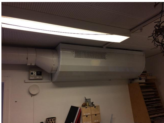
Figur 4.3. Ventilationsanlæg (indblæsning)
