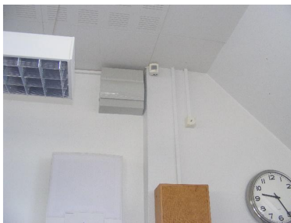
Figur 4.24. PIR-sensor placeret på væg
