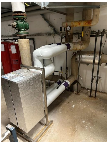
Figur 5.1. Varmesystem (fjernvarmeveksler)
