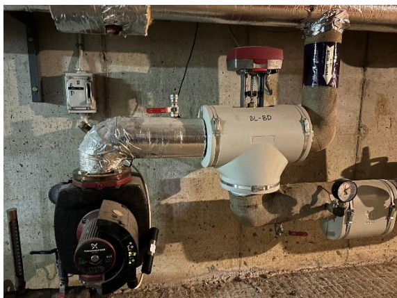
Figur 5.3. Varmesystem med omdrejningstalregulerbar cirkulationspumpe
