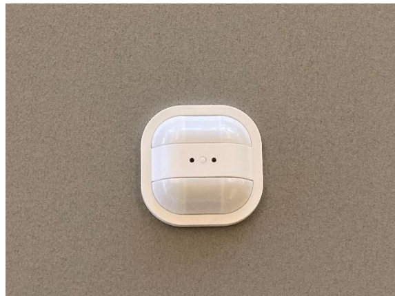
Figur 4.39. Bevægelses- og dagslyssensor
