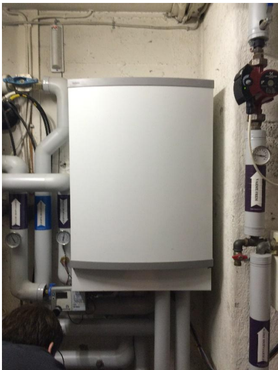
Figur 4.6 Varmeanlæg (fjernvarmeveksler)
