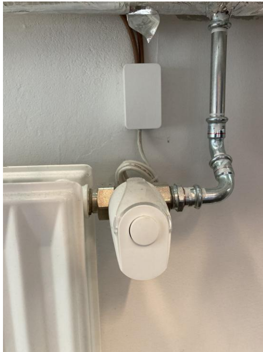
Figur 4.21. Motorventil på radiator
