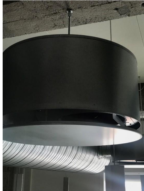
Figur 4.36. VAV-armatur (indblæsning)
