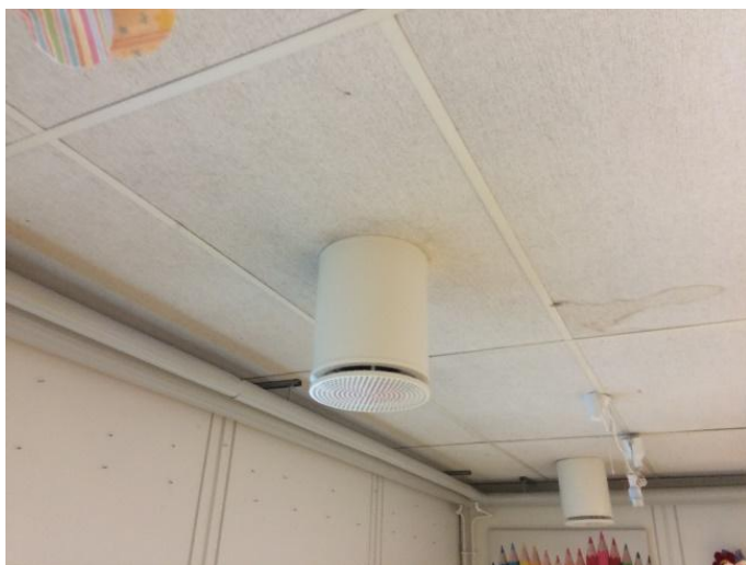
Figur 4.14. Indblæsningsarmaturer
