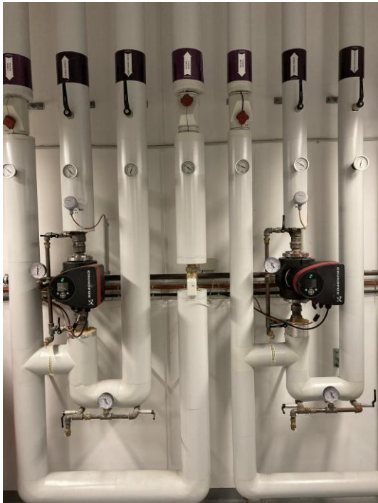
Figur 4.20. Blandekredse til radiatorsystemer og omdrejningstalsregulerbare cirkulationspumper
