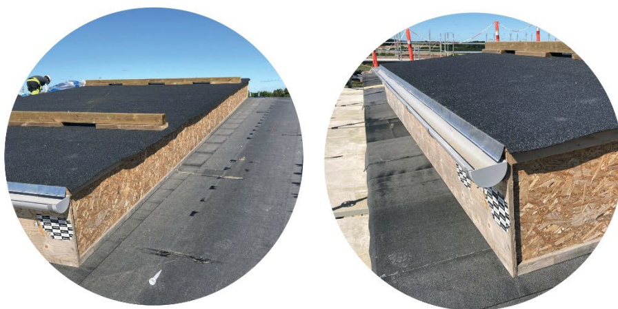
Foto ii + iii: Interimstagkassette ned midlertidig tagrende ligger klar til at give overdækning ved regnvejr og/eller endt arbejdsdag.
