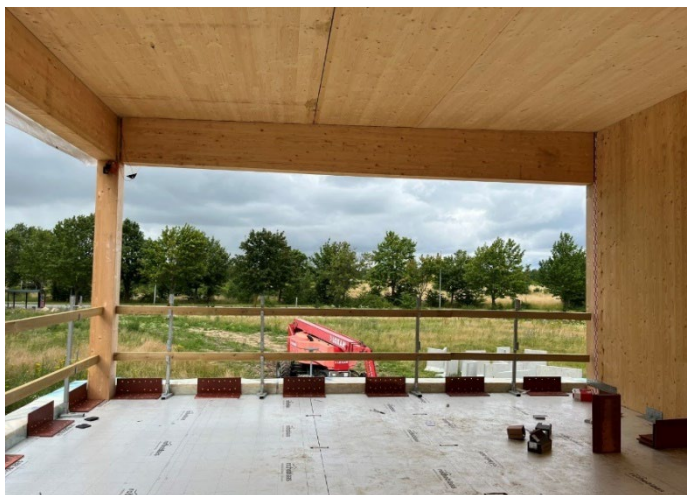
Figur 3: Åben trækonstruktion uden overdækning eller presenninger.
