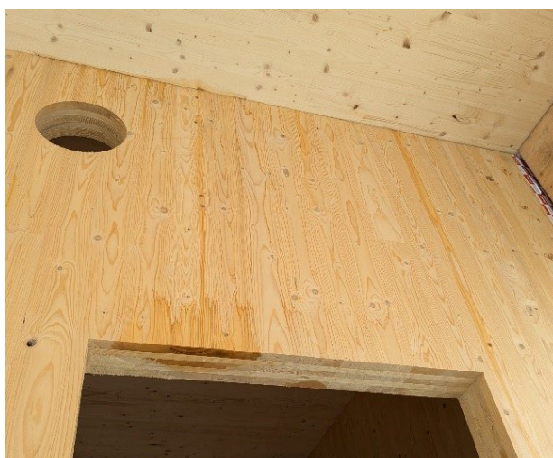
Figur 6. Vandmærker på CLT. Del af en komplet fugtstrategi er også en aktionsplan for uventede hændelse som denne.
