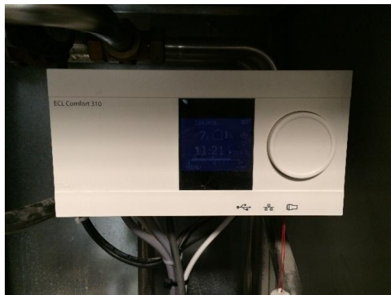
Figur 4.7 Udetemperaturkompenseringsanlæg (ECL fra Danfoss)
