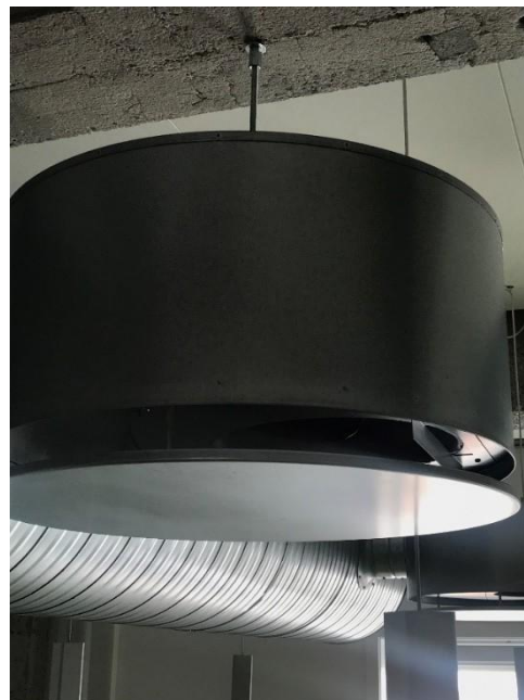
Figur 4.36. VAV-armatur (indblæsning)
