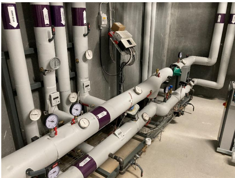
Figur 4.25. Blandekredse til radiatorsystem og omdrejningsregulerbare cirkulationspumper
