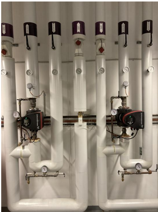
Figur 4.20. Blandekredse til radiatorsystemer og omdrejningstalsregulerbare cirkulationspumper
