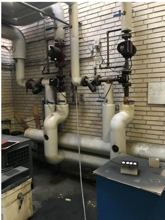
Figur 4.27. Blandekredse til radiatorsystem og omdrejningsregulerbare cirkulationspumper
