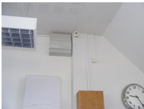
Figur 4.24. PIR-sensor placeret på væg
