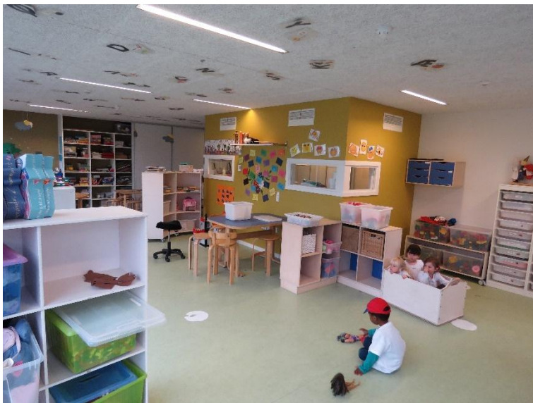
Figur 17 Belysningsanlæg med LED-armaturer samt PIR- og dagslyssensorer
