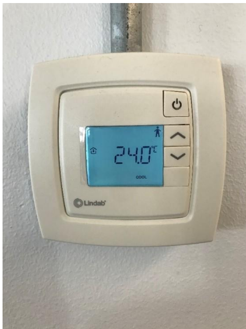
Figur 4.35. Temperatursensor placeret på væggen
