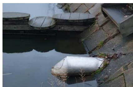
Figur 3.2: Eksempel på eftermonteret dykket fraløb. Fraløbet er her i metal, fordi det sidder et sted, hvor børn/folk må forventes at træde ud på. Det kan sagtens være almindelig PVC-rør, der sættes ind i betonfraløbet. (Foto: T. Aabling).
