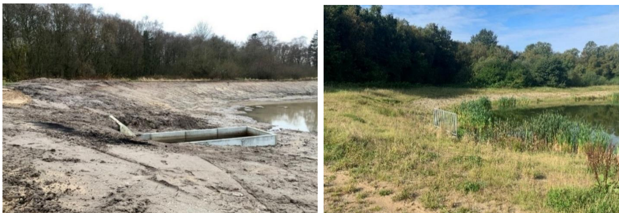
Figur 4.7: Eksempel på sandfangkasse i beton, opdelt i 4 elementer, fra bassin-projekt i Silkeborg. Til venstre ses forbassinet i anlægsfasen. Til højre ses bassinanlæg ca. 1 år efter endt udførelse, hvor afslutning på kassen med rækværk og overkant af gavl kan ses i front af sandfangkassen (Foto: NIRAS).
