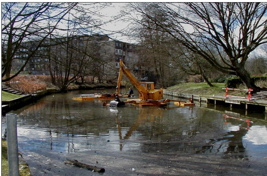
Figur 3.6: Eksempel på vådopgravning. Sedimentet opgraves til pram, der sejles bort til tømning (Foto: T. Aabling).
