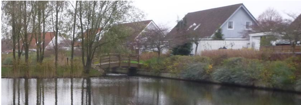
Figur 3.3: Eksempel på lodret sider i regnvandsbassiner, med beplantning. (Foto: T. Aabling).
