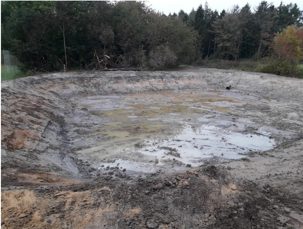
Figur 4.9: Eksempel på etablering af regnvandsbassin med bentonitmembran (Foto: VAM A/S, 2023).
