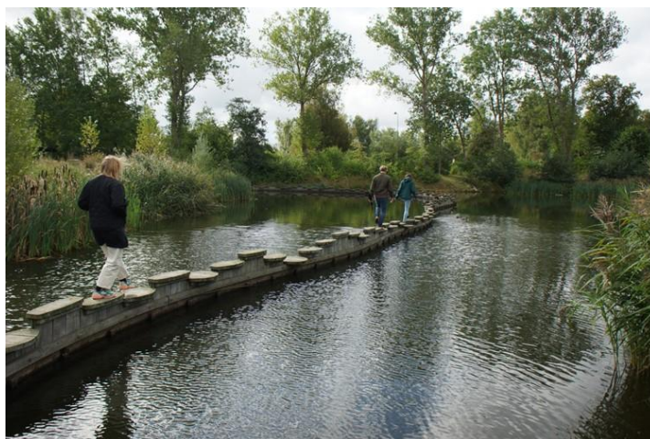
Figur 4.2: Eksempel på etablering af skillevæg i et regnvandsbassin i Gladsaxe Kommune, hvor ind- og udløb oprindeligt er sket i samme brønd. Væggen sikrer, at vandet på vejen fra ind- til udløb strømmer gennem hele bassinet (Foto: WSP).
