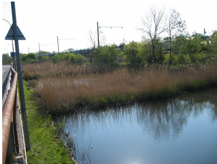
Figur 4.1: I Albertslund Kommune har WSP etableret et regnvandsbassin, der er opdelt i seks underbassiner, adskilt af beplantede jordvolde. Der ses en effektiv tilbageholdelse af suspenderet stof med denne løsning (Foto: WSP).
