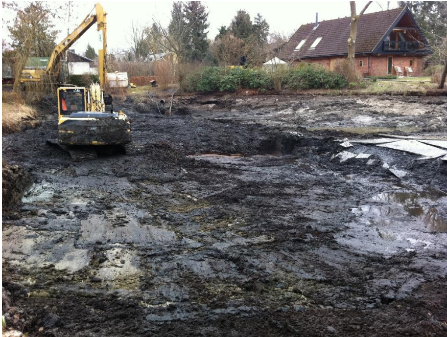
Figur 3.5: Eksempel på tøropgravning af voldgrav. Her er der ikke afvandet og oppumpet tilstrækkeligt, idet der ligger frit vand (Foto: T. Aabling).
