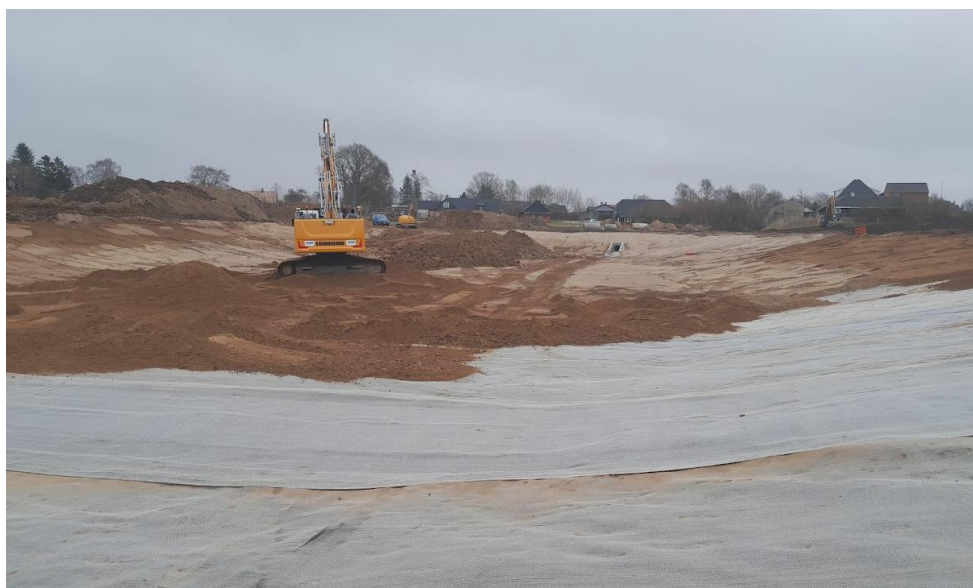
Figur 4.10: Eksempel på etablering af regnvandsbassin med bentonitmembran (Foto: VAM A/S, 2023).
