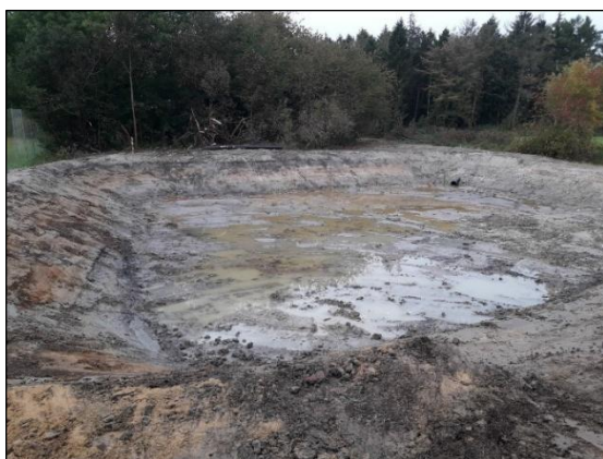
Figur 8.1. Vådt regnvandsbassin med in-situ lermembran (Foto: J. Knudsen og J. Pedersen).
