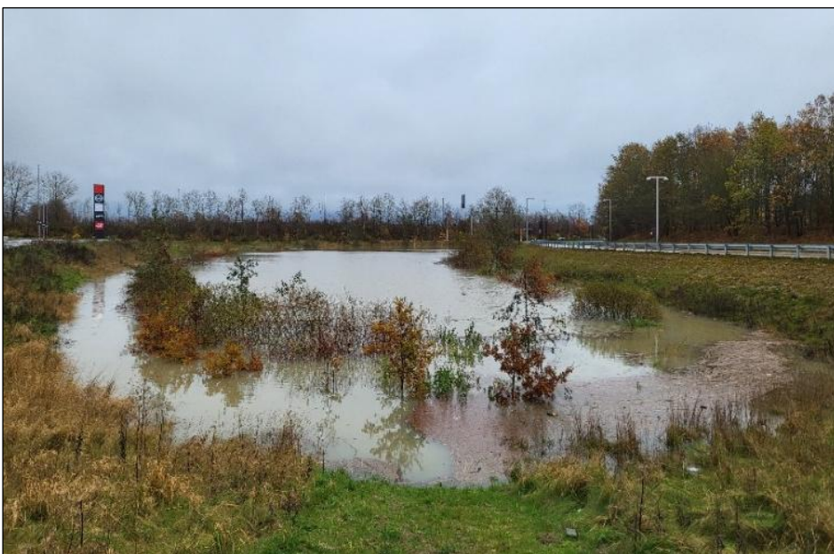
Figur 5.1. Vådt regnvandsbassin, hvor øverste billede viser normal vandstand og nederste billede viser samme våde regnvandsbassin, hvor forsinkelsesvolumenet er udnyttet efter længere tids regn (Foto: K. Nielsen).
