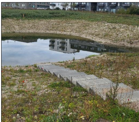
Figur 7.3. Eksempler på trapper, til brug ved driftsarbejde. I billedet til højre er fraløbet markeret med en stor sten (Foto: K. Nielsen).
