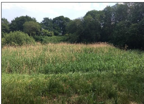
Figur 7.8. Våde regnvandsbassiner, hvor renselagets højde er kommet under 0,75 meter og bevoksningen er vokset ind i bassinet (Foto: K. Nielsen).
