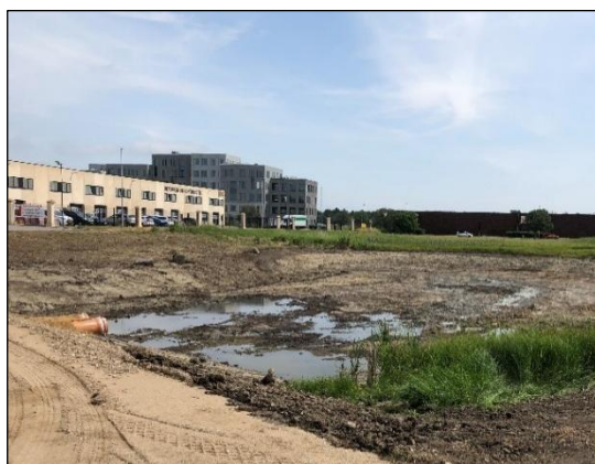
Figur 8.1. Vådt regnvandsbassin med in-situ lermembran (Foto: J. Knudsen og J. Pedersen).
