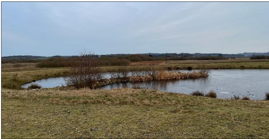
Figur 5.5. Eksempler på opbremsning og forlængelse af vandets vej i bassinet (Foto: K. Nielsen og T. Holm).
