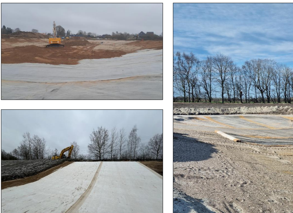
Figur 8.2. Udlægning af bentonitmembran i forskellige våde regnvandsbassiner (Foto: J. Knudsen, T. B. Pedersen og F. Mosbæk).
