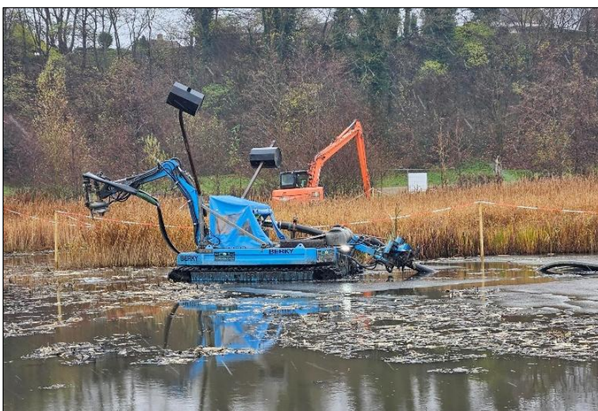
Figur 9.1. Eksempler på tøropgravning (øverst) og brugen af cuttersuger, ved oprensning af våde regnvandsbassiner (Foto: T. Aabling og B. Shabeer).
