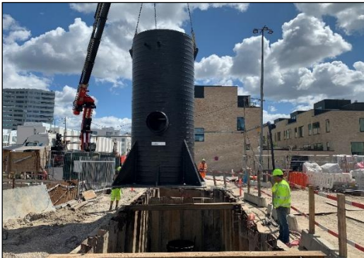
Figur 7.2. Eksempler på lukkede sandfangselementer fra henholdsvis Uponor, Wavin og Watercare (Foto: M. A. Christensen, J. Groth og T. Mortensen).
