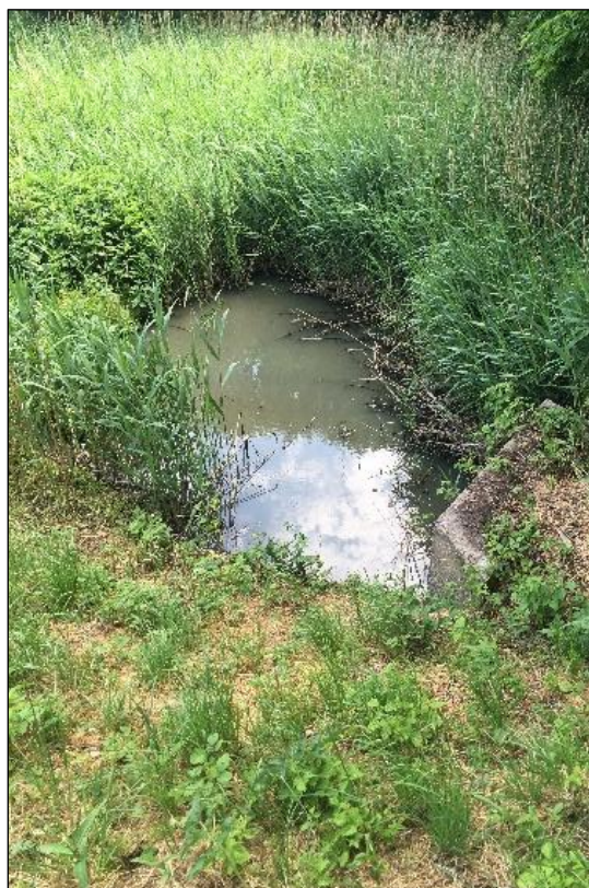
Figur 7.8. Våde regnvandsbassiner, hvor renselagets højde er kommet under 0,75 meter og bevoksningen er vokset ind i bassinet (Foto: K. Nielsen).
