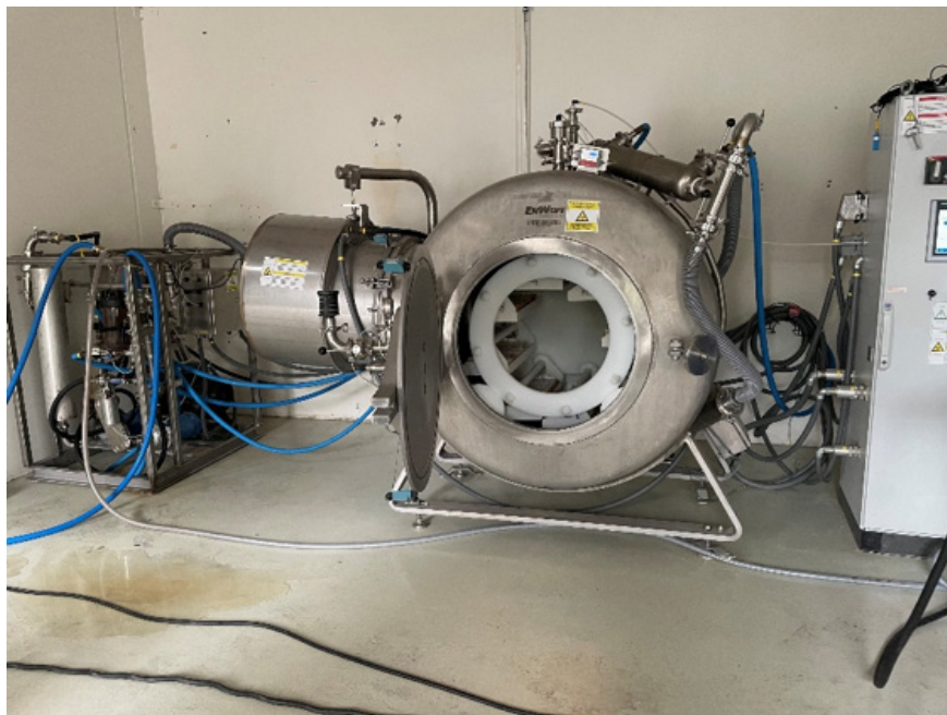
Pilotanlæg til demonstration af kombineret vakuum- og mikrobølgetørring.
