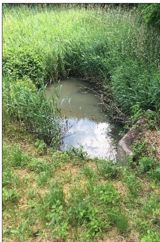
Figur 7.8. Våde regnvandsbassiner, hvor renservolumen er kommet under 0,75 meter og bevoksningen er vokset ind i bassinet (Foto: K. Nielsen).
