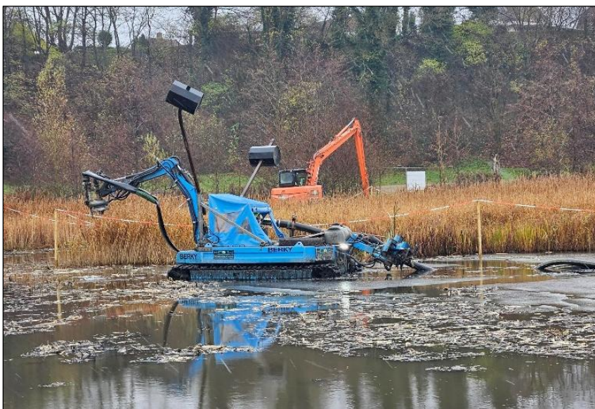
Figur 9.1. Eksempler på tøropgravning (øverst) og brugen af cuttersuger, ved oprensning af våde regnvandsbassiner (Foto: T. Aabling og B. Shabeer).
