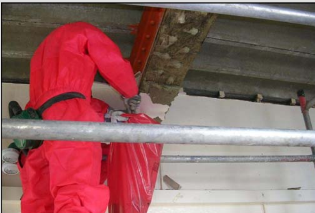
Handskeposer anvendt til kontrolleret fjernelse af asbestisolering
