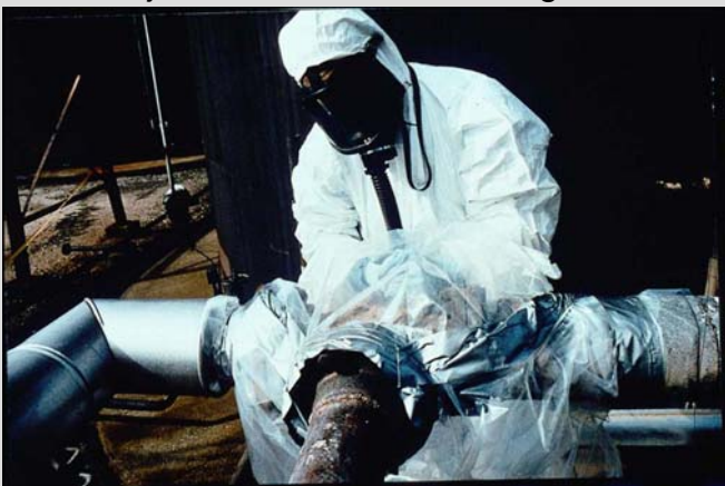
Handskeposer anvendt til kontrolleret fjernelse af asbestisolering
