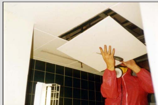
Forsigtig nedtagning af asbestplader
